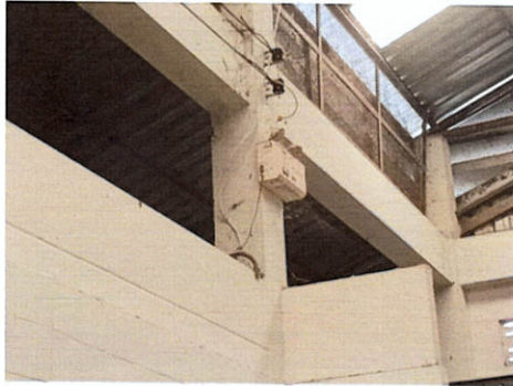
เครื่องไฟฟ้าฉุกเฉิน 035 57 0002 (โรงฆ่าสัตว์)
