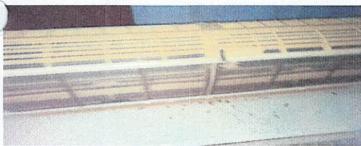
เครื่องปรับอากาศ 420 - 50 - 0019
