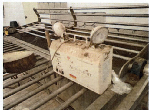
ไฟฟ้าฉุกเฉิน 035 53 0001 (โรงฆ่าสัตว์)
